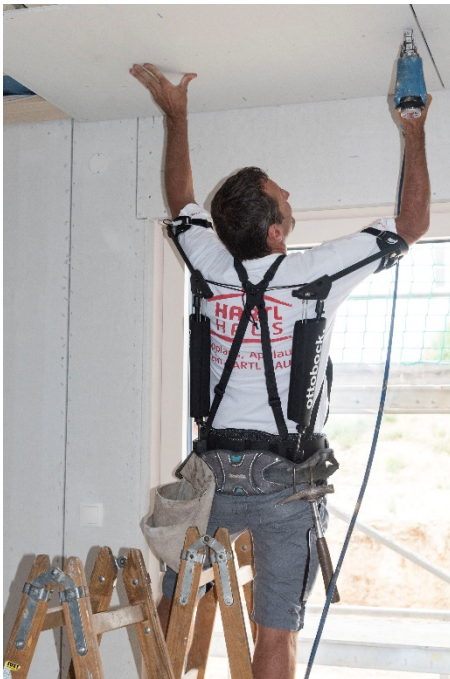
Foto: HARTL HAUS_Exoskelett_Montage.jpg
